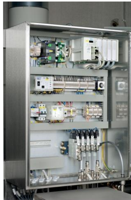
Автоматика горелки
