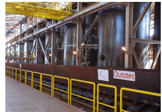
锰烧结设备 Kalagadi Manganese公司 南非
